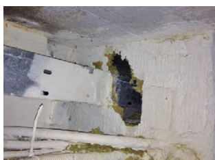
Diera v protipožiarnej upchávke káblového kanála vyhrzená hlodavcami je veľké riziko a varovaním pre zodpovedné osoby
