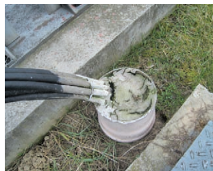
Mäkké protipožiarné upchávky v exteriéri dlho nevydržia a treba ich často renovovať. Zvyšujú sa tým prevádzkové náklady a navyše aj riziko požiaru.
