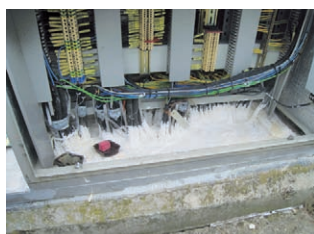
Je záhadou, ako sa hlodavce dostanú do takto utesenenej skrine rozvádzača. Otravu na myši však nemôžeme pokladať za účinnú ochranu.
