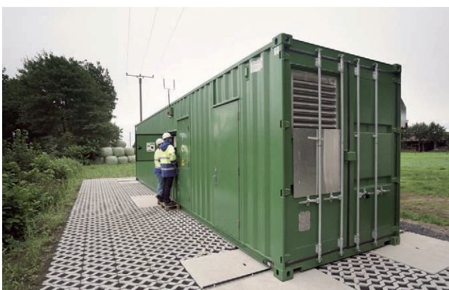
Obr. 1 Vonkajší pohľad na kontajner Parker Energy Storage pre RWE Westnetz
