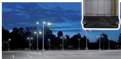
DEHNcord od výrobcu DEHN + SÖHNE GmbH osadený v stožiarí s LED svietidlom
